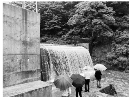
県・市町連携会議 (R7.6 水海川水力発電所視察)
