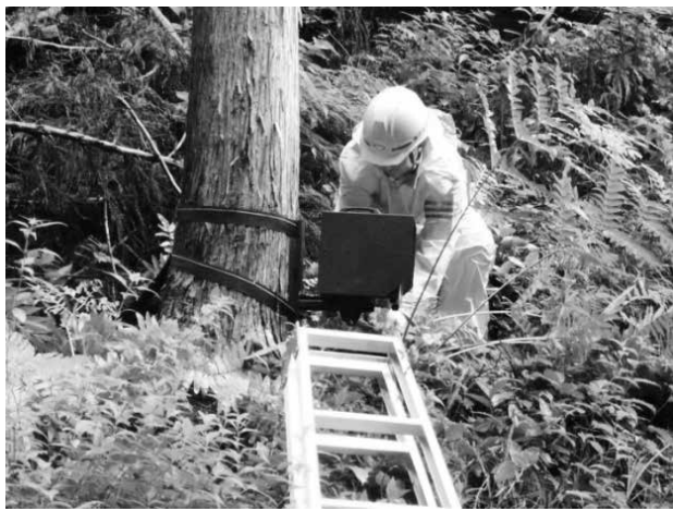
監視カメラの設置
