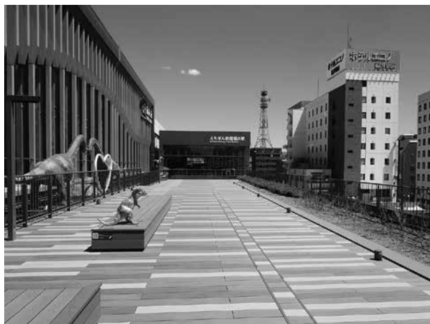
ウッドプラスチックのウッドデッキ（福井市）
