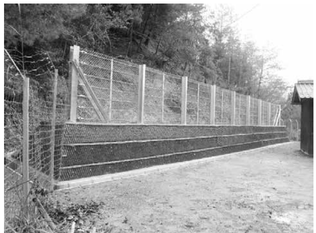
補強土壁工法（東黒田地区 若狭町東黒田）
