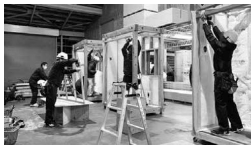
断熱施工講習会の様子
