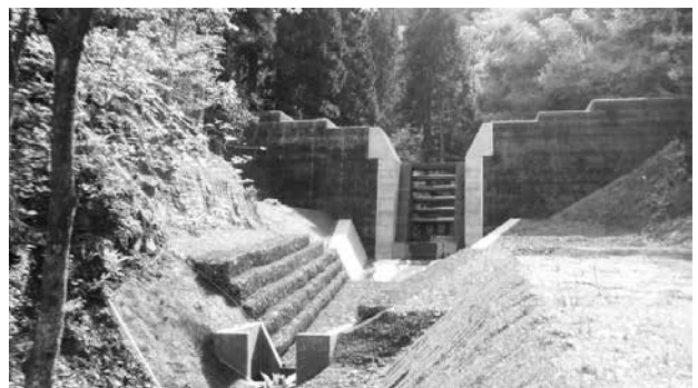
透過型砂防堰堤（滝ヶ谷川 敦賀市田尻）
