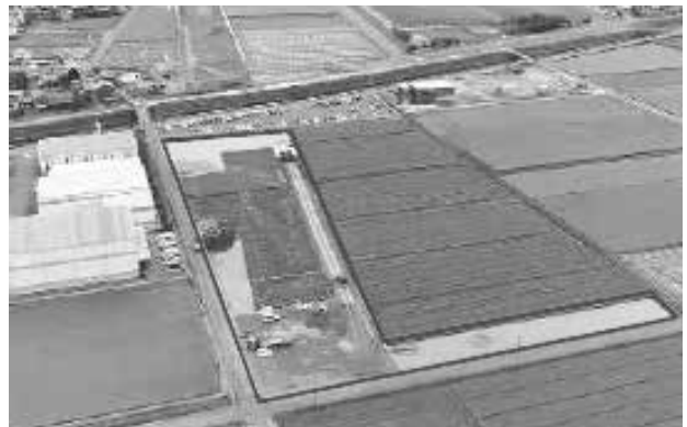
盛土施工の現場
