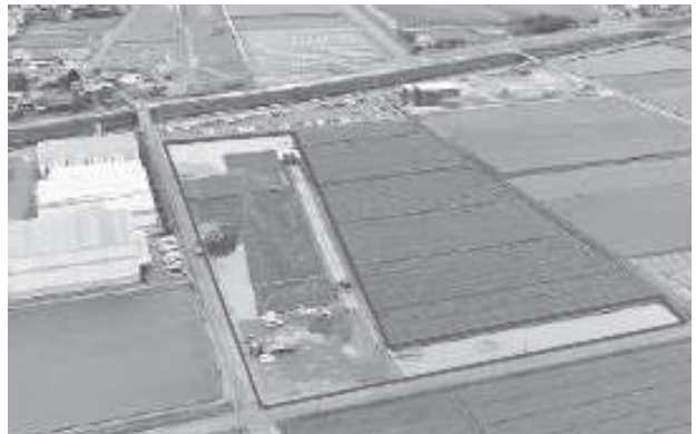
盛土施工の現場
