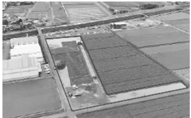
盛土施工の現場
