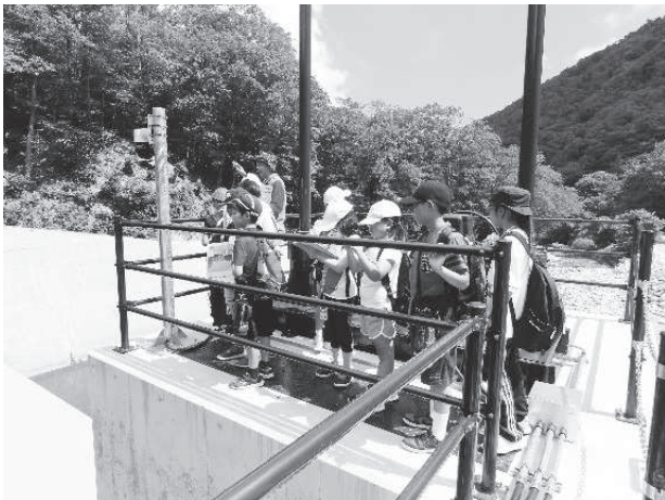
COOP 黒河川水力発電所の取水口を見学する様子（第1回）
