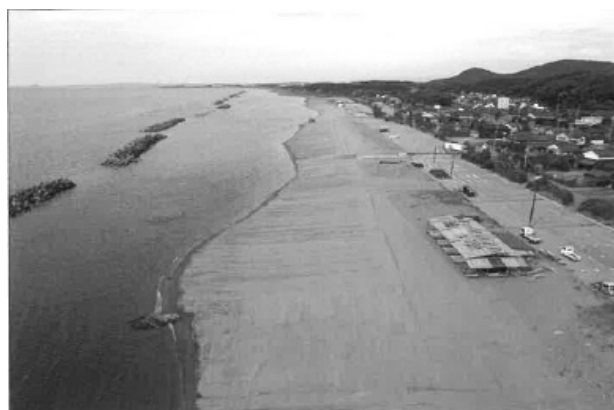
自然環境に配慮して整備された海岸（福井市浜住海岸）
