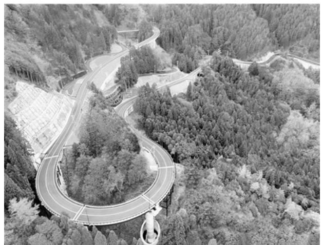
景観に配慮した橋りょう整備の例 (主要地方道 坂本高浜線)
