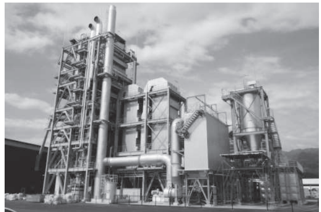
木質バイオマス発電施設（大野市）
