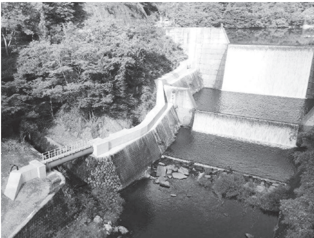
再エネ活用地域振興プロジェクト事業の支援により建設された小水力発電所（おおい町）
