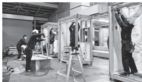
断熱施工講習会の様子
