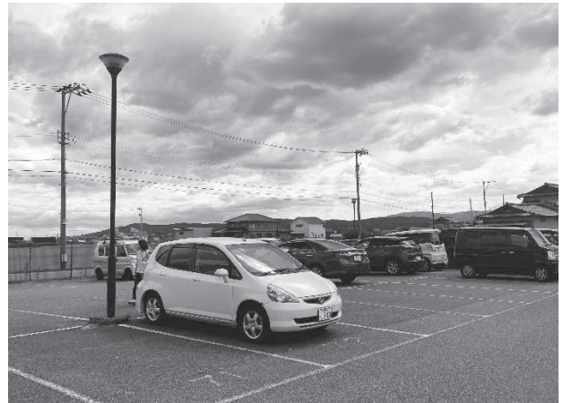
県営パークアンドライド駐車場（西長田駅駐車場）
