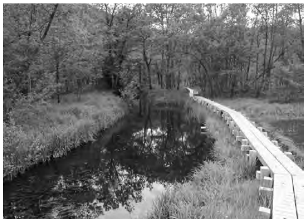
池河内湿原（完成した木道）
