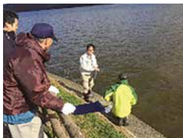
写真1 護岸形状調査
