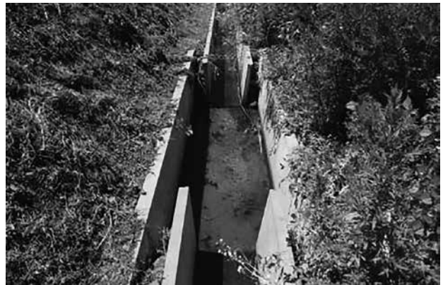
土砂だまりの設置 (水生生物の生息場所確保)
