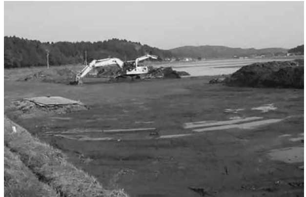
掘削した水田表土の再利用 (田面植物復帰後の生育環境保全)
