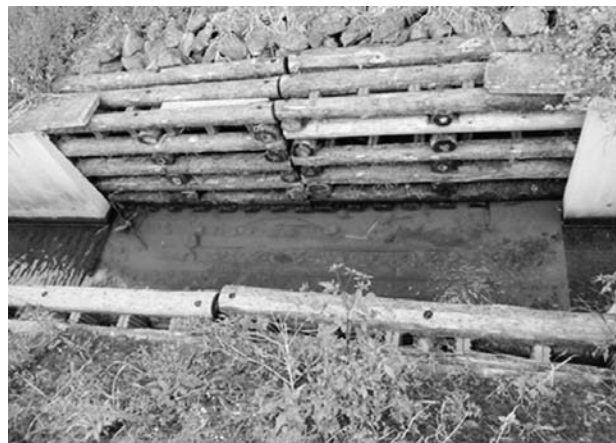
土砂だまりの設置（水生生物の生息場所確保）
