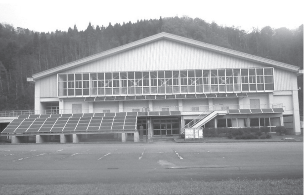
(消防学校 太陽光発電設備)
