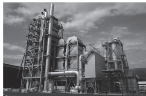
木質バイオマス発電施設
