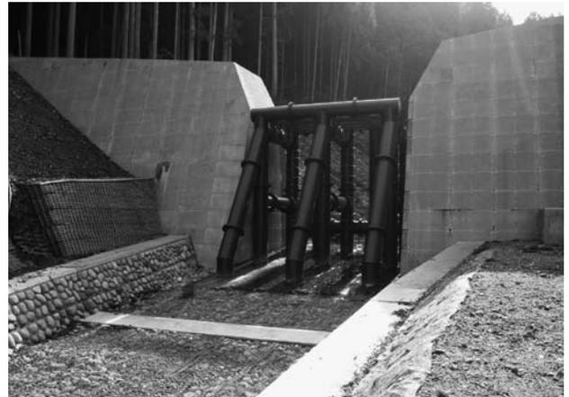
透過型砂防堰堤 (H26完成 若狭町新道 順禮谷川)
