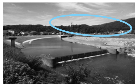
高水護岸への覆土直後の状況
