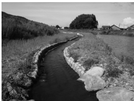
魚道水路整備状況
