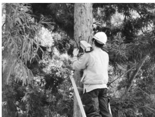
監視カメラの設置
