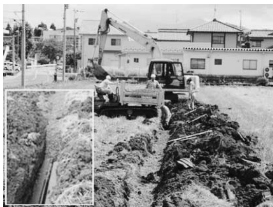
弘法大師ファームみつまた（集落営農組織）による 廃瓦チップを利用した暗渠排水工事（越前市）
