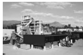
木質バイオマス発電施設の外観
