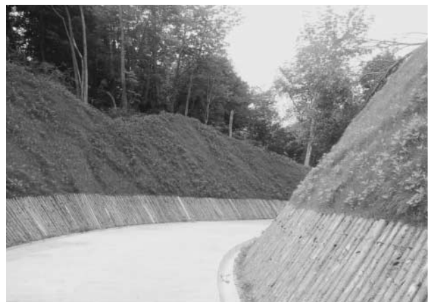
間伐材丸太伏工
