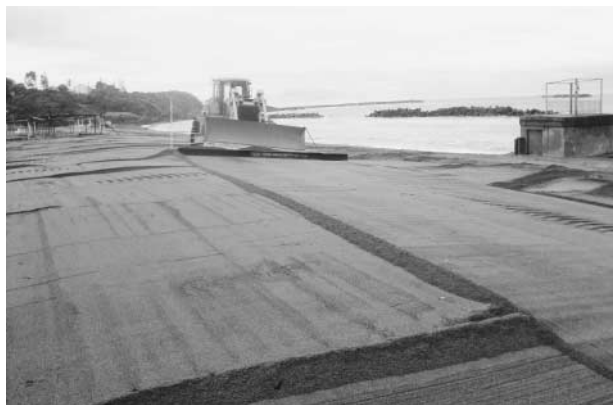
浚渫砂による養浜（福井市浜住海岸）
