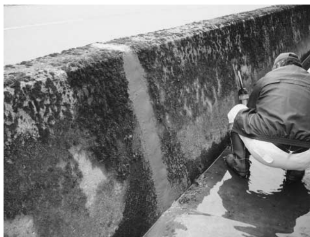
地域住民による水路の目地補修 （大野市 アバンセ乾側の環境を良くする会）
