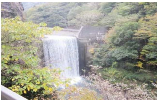
導入が検討されている砂防ダムの例
