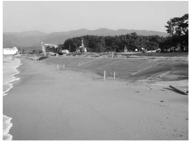
養浜の施工状況
