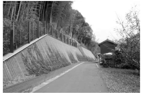
壁面緑化擁壁（寺谷地区）
