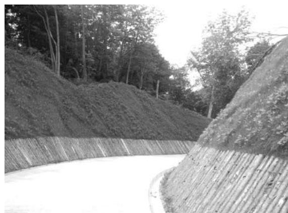
間伐材丸太伏工
