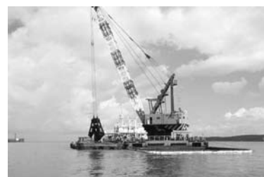
堆積砂の浚渫（福井港）
