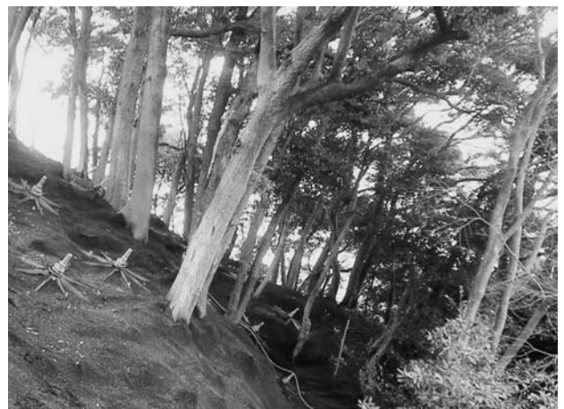
樹木を残す法面工（吉崎地区）
