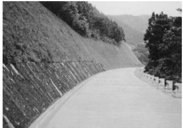
間伐材丸太伏工
