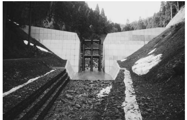
透過型砂防堰堤（鍋谷川）
