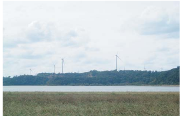
電源開発株式会社風力発電
