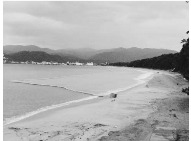
汚濁防止膜による濁水の拡散防止
