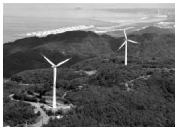
国見岳風力発電所
