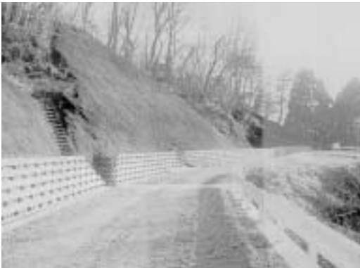
切土法留（ウッドブロック）
