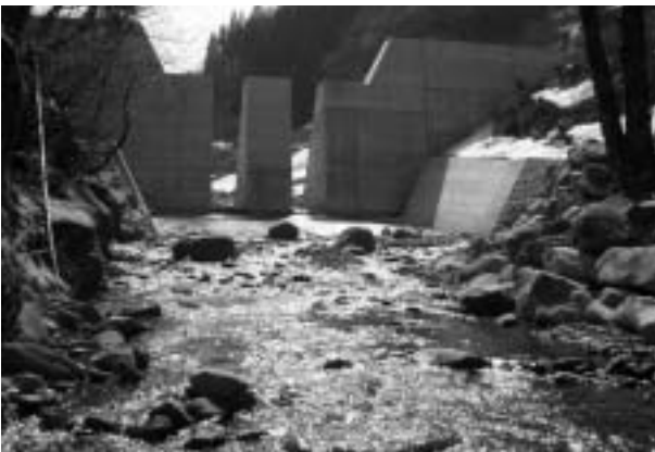
ちなぼらだに 智那洞谷川の透過型堰堤
