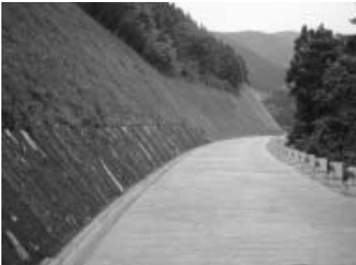
間伐材丸太伏工
