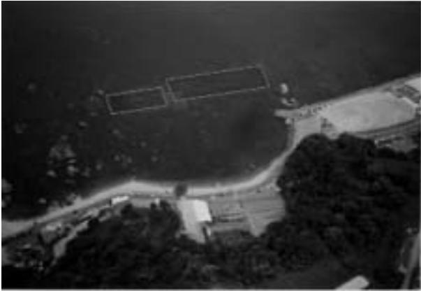
水面下に設置された人工リーフ（長須浜海岸）
