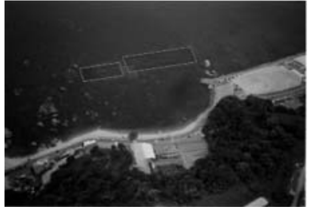
水面下に設置された人工リーフ（長須浜海岸）
