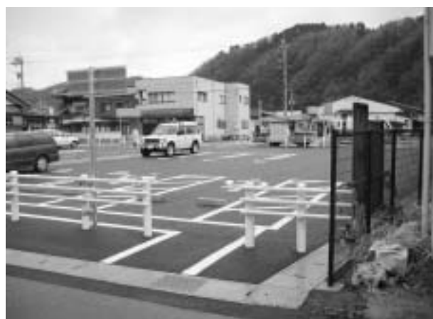
県営永平寺口駅駐車場
