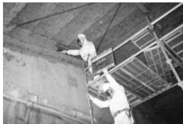
アスベスト排出等作業
