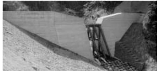
蒲生大川の鋼製スリット堰堤
