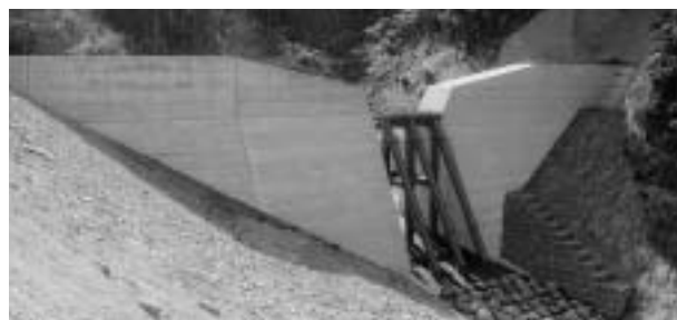
蒲生大川の鋼製スリット堰堤
