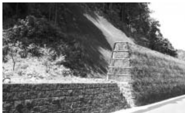
高浜町南団地地区
