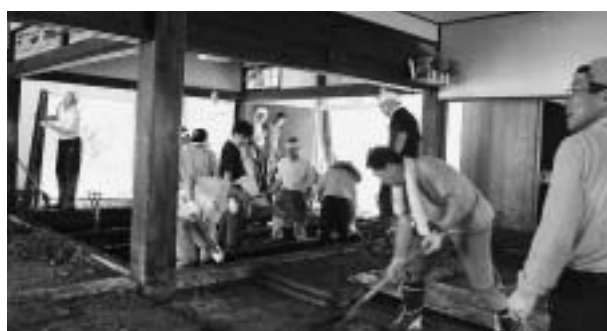
ボランティアによる復旧作業
