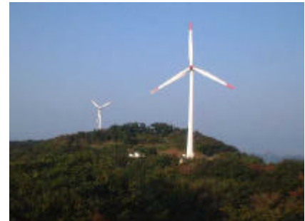
（福井市国見岳風力発電所）
