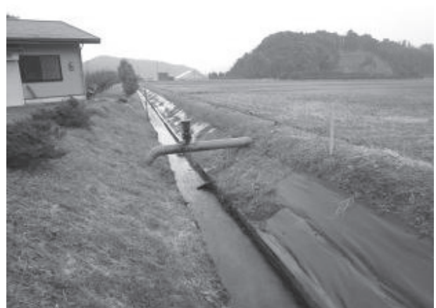
図8 島之内排水機場
