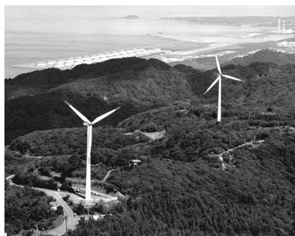
〔国見岳風力発電所〕
