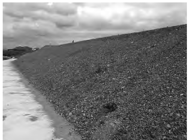
既存堤防の表土による覆土（高水護岸覆土後）
