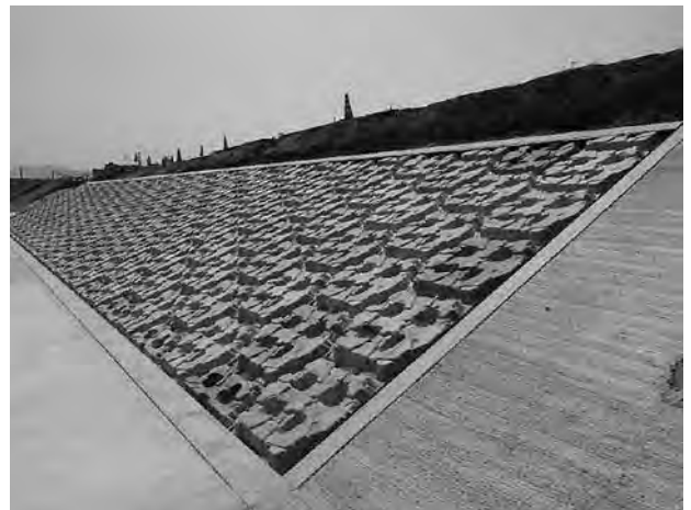
覆土型連接ブロック（高水護岸覆土前）
