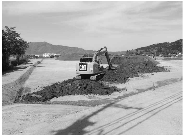
掘削した表土の再利用
