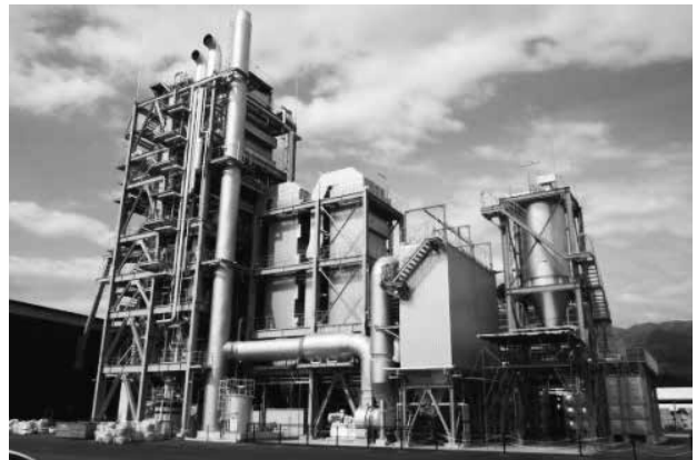
木質バイオマス発電施設（大野市）
