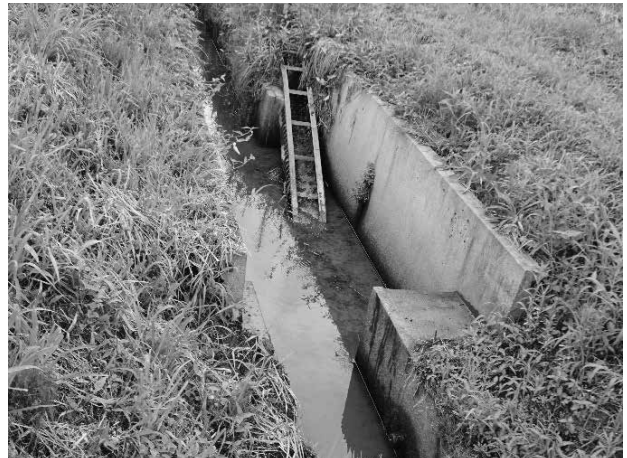
水田魚道の設置による水系の連続性の確保 (越前町)
