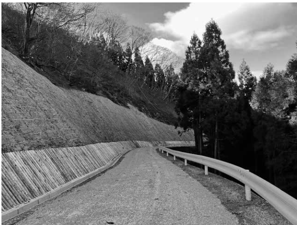
間伐材の活用例 (林道 若狭遠敷線 丸太伏工)
