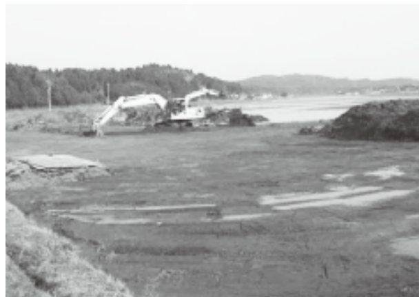
掘削した表土の再利用
