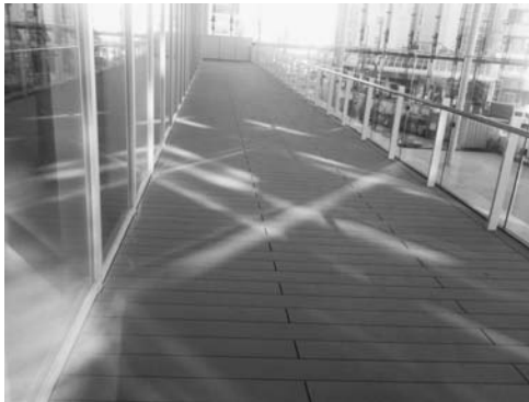
ハピリン（福井市）テラスに使用されたウッドプラスチック製品
