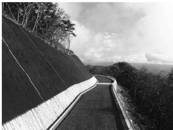
間伐材の活用例 (林道越前南部線 木材チップ吹付や丸太伏工)
