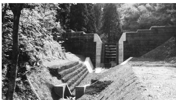
透過型砂防堰堤 (H29完成 滝ヶ谷川 敦賀市田尻)
