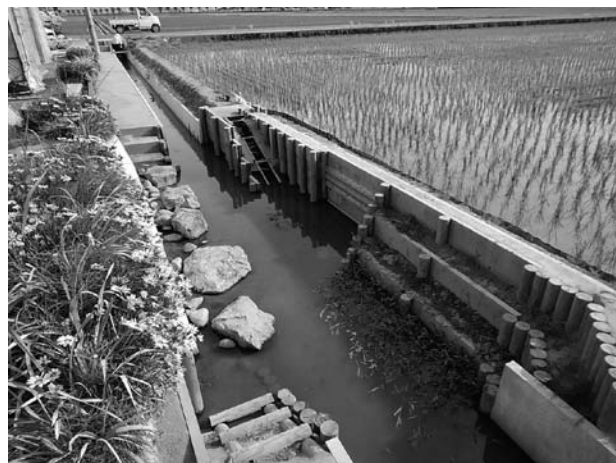
魚や小動物の生息・往來に配慮した水路の整備 (坂井市)
