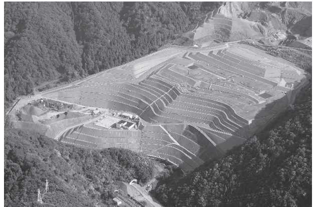
敦賀市民間最終処分場全景（平成28年10月）
