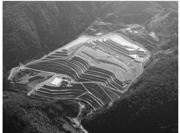
敦賀市民間最終処分場全景（平成24年11月）
