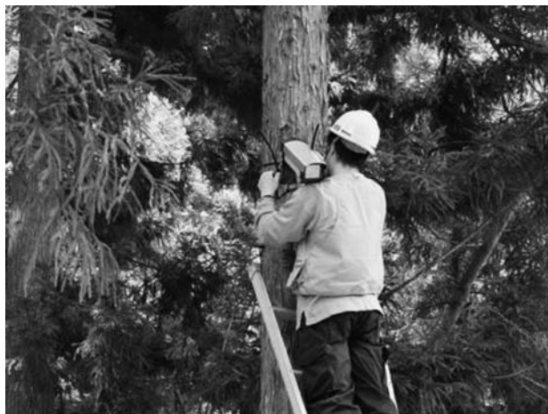
監視カメラの設置
