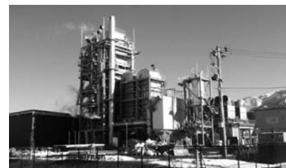
木質バイオマス発電施設
