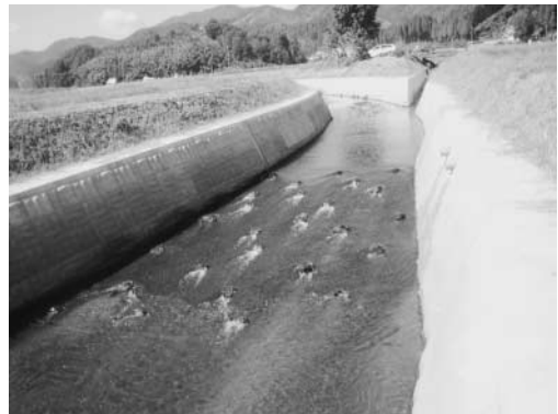
急流部での置石設置による多様な流速の確保
