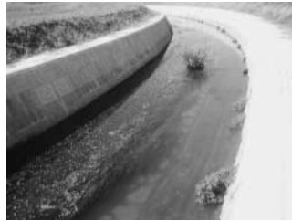
木工沈床による魚巢スペースの確保
