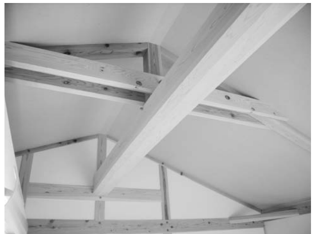
事例(住宅の横架材へ県産スギを活用)
