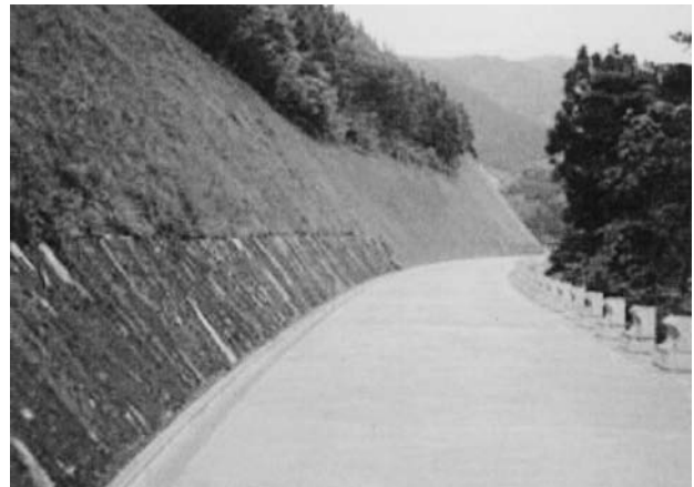
間伐材丸太伏工
