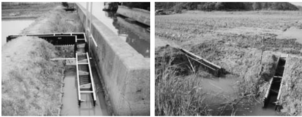
水田と水路との間に設置した「水田魚道」
