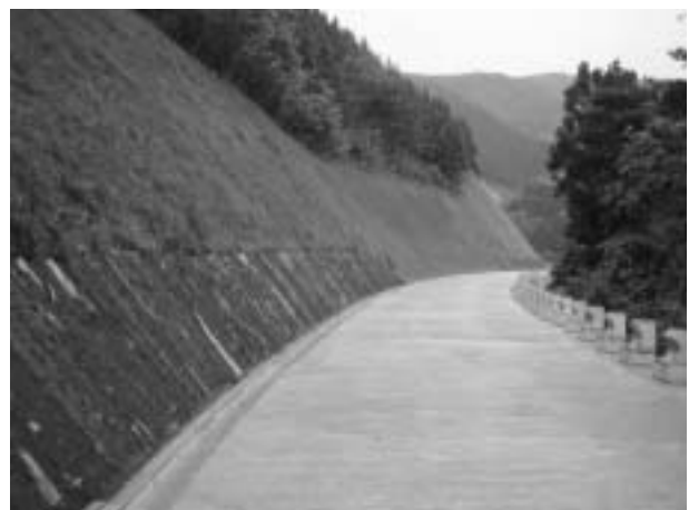
間伐材丸太伏工
